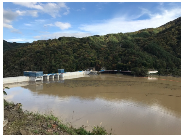
図1 試験湛水中に満水となった八ッ場ダム (2019年10月20日：筆者撮影)
